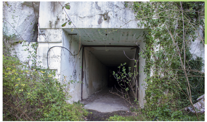
Entrée de la cavité avant travaux
